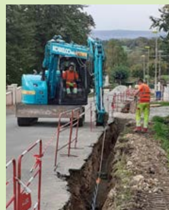
Enfouissement réseaux rue Yves Montand
