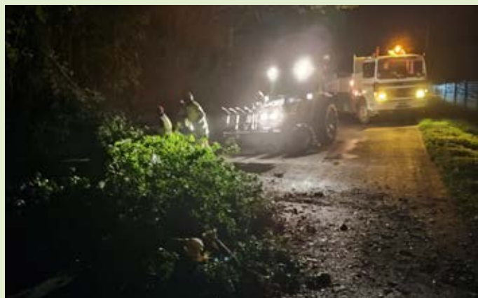
Travaux nocturnes à la foresterie
